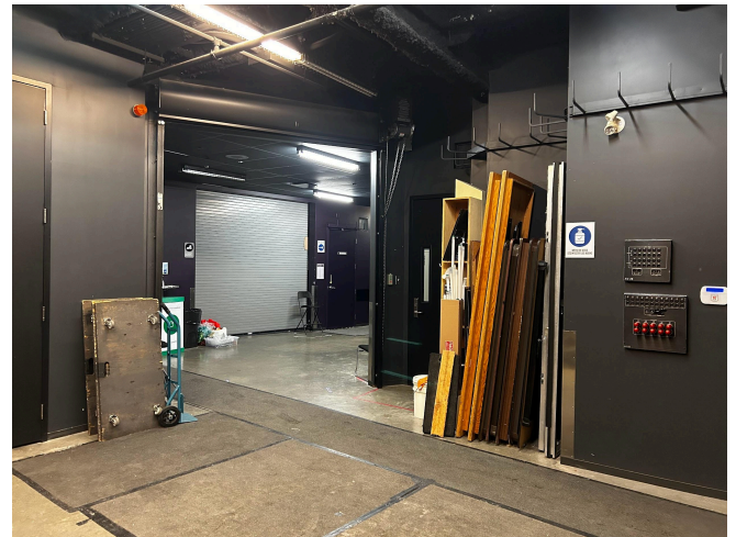
Accès à la scène depuis aire de déchargement
